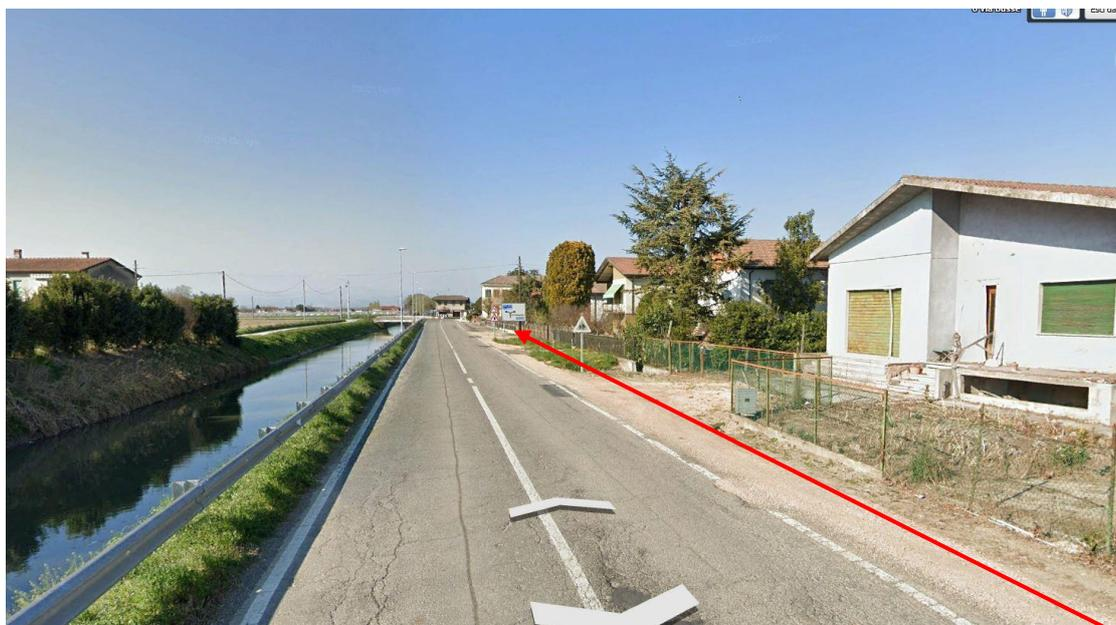
La pista avrà larghezza minima di mi. 2,50 e separata dalla sede stradale da un'aiuola spartitraffico della larghezza minima di mi. 0,50 e si realizzerà una banchina stradale di 50 cm lungo il lato di realizzazione della pista ciclabile.
